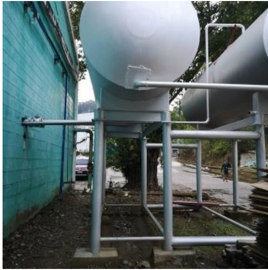
菲律賓子公司的染整冷卻水回收裝置
